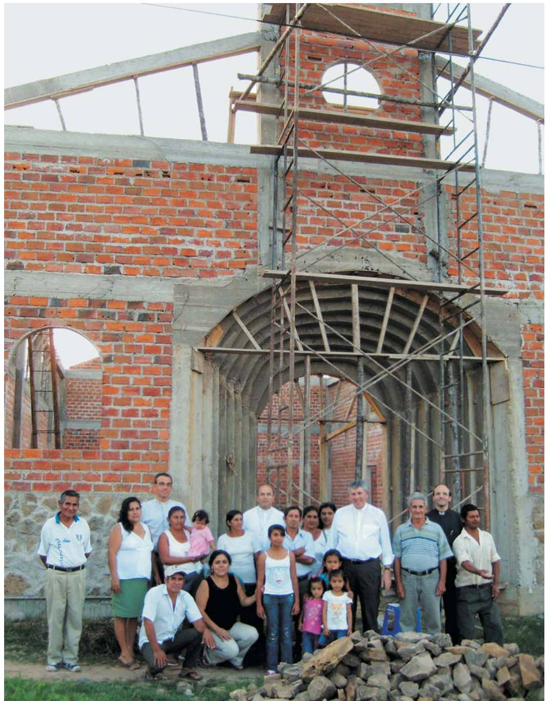
El Sr. Arcobispo, con don Rafael Escudero y algunos sacerdotes y fieles en la visita a las obras de la iglesia del Consuelo.
