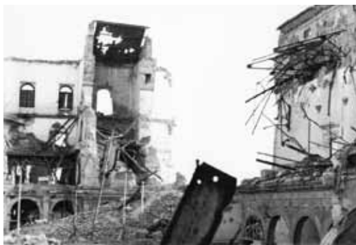
Efectos de la mina del 18 de septiembre sobre el flanco suroeste del Alcázar (Foto propiedad de Víctor Girona).
