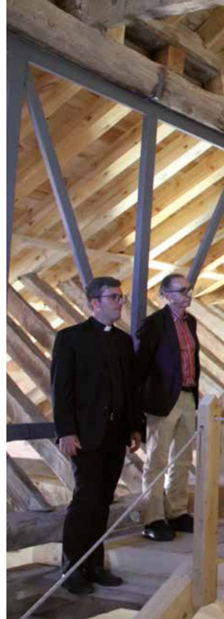
El Sr. Arzobispo bendijo las obras de reparación
